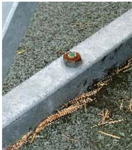
Abb. B.1.6–18 Bei der Wahl der Materialien muss beachtet werden, dass Korrosion sicher ausgeschlossen wird.
