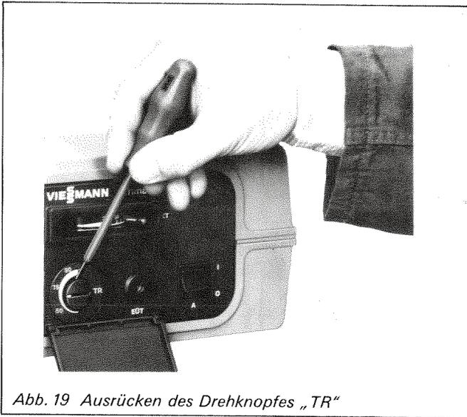
Abb. 19 Ausrücken des Drehknopfes „TR“
