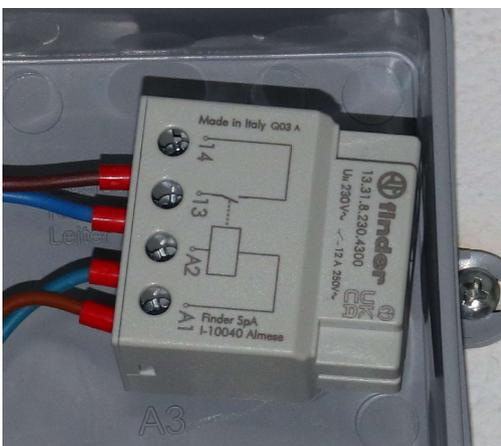
Das Viessmann Anschlusskabel an der Steuerung der Vitocal 060-a anschließen (wie man die Verkleidung öffnet steht in der Montageanleitung der Brauchwasserwärmepumpe):
