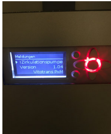
Fehler Zirkulationspumpe.
