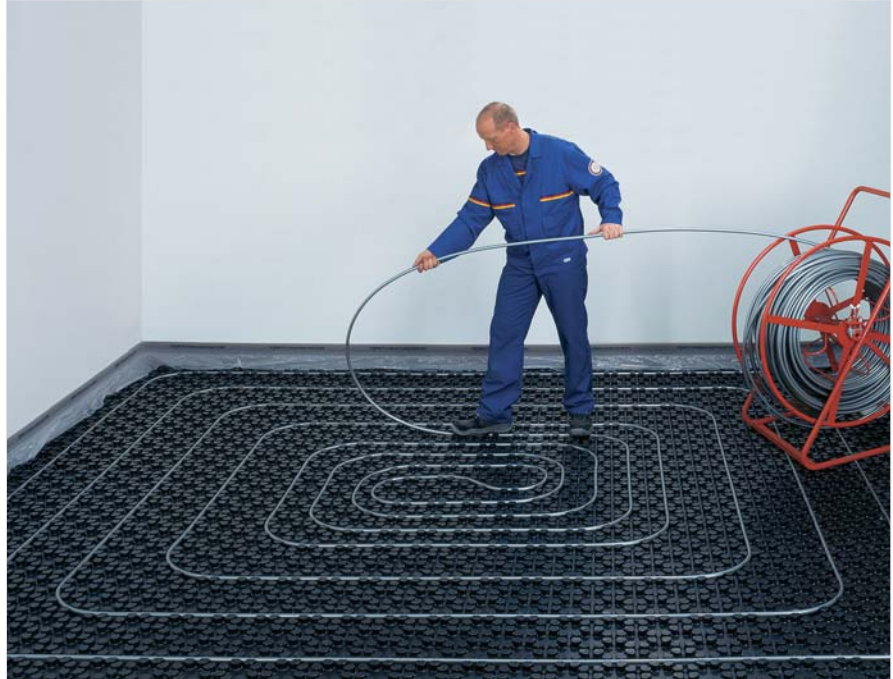
Bild 10: Verlegung eines Fußboden-Heiz-/Kühlsystems
