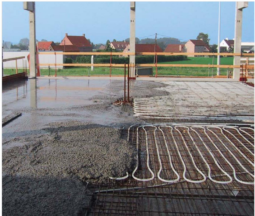
Bild 11: Bauteilaktivierung/Betonkernaktivierung – Erstellung der Zwischendecke mit Rohrsystem
