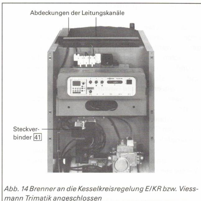
Abb. 14 Brenner an die Kesselkreisregelung E/KR bzw. Viessmann Trimatik angeschlossen
