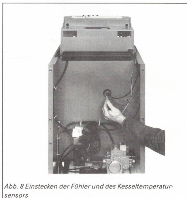
Abb. 8 Einstecken der Fühler und des Kesseltemperatursensors
