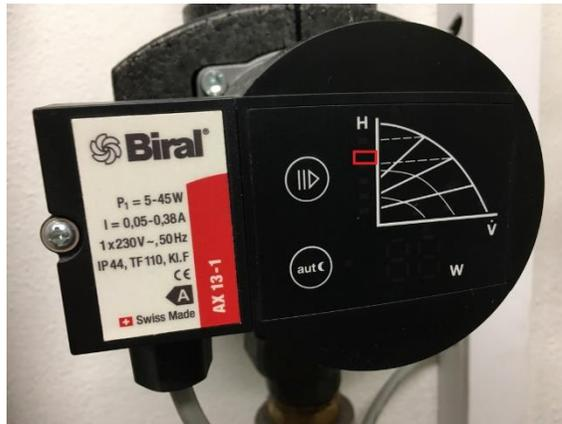
Bei der Heiskreisförderpumpe ist der markierte Bereich eingestellt → geregelte Betrieb konstant Druck (für Fußbodenheizung mit Thermostatventil)
